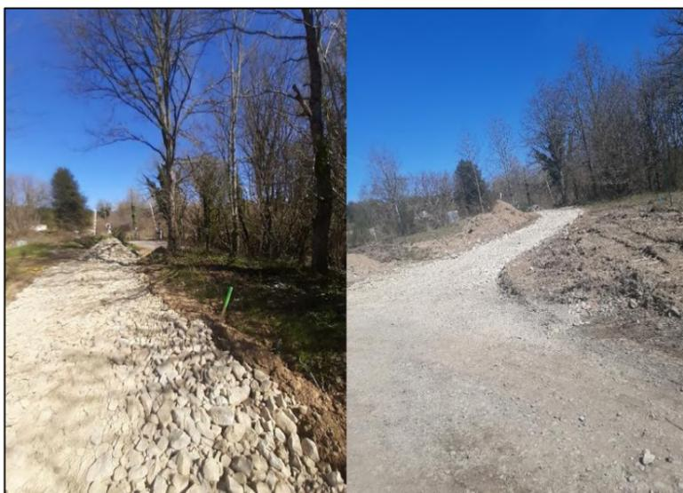
Figure 34 : Mise en place des pistes lors d'un chantier photovoltaïque
