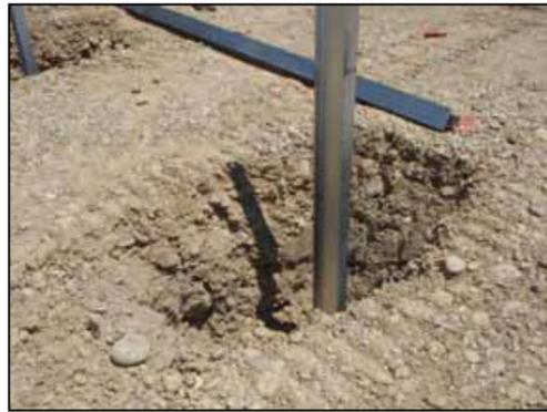
Dans certains types de sol, il est possible d'utiliser des pieux enfoncés dans le sol par le biais d'une batteuse, sans avoir besoin de fondations en béton. Les pieux ou poteaux servant de support sont enfoncés dans le sol sur plusieurs dizaines de centimètres puis recouverts de béton ou non.
